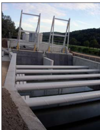
Elektrárna u jezu v Bělově. Foto: R. Nelešovská.
