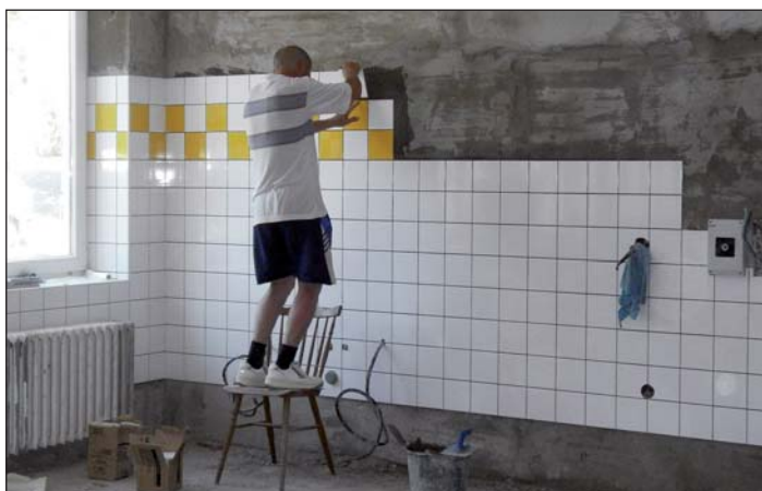
Rekonstrukce kuchyně v MŠ.
