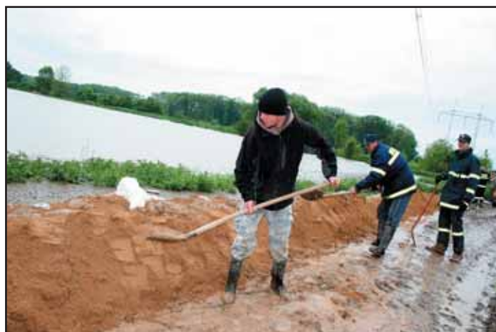
Pracovníci obce s hasiči zpevňují hráze.
