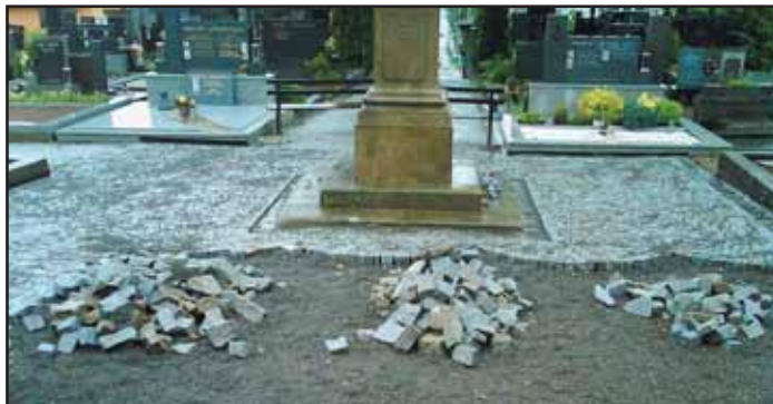
Oprava chodníku na hřbitově.
