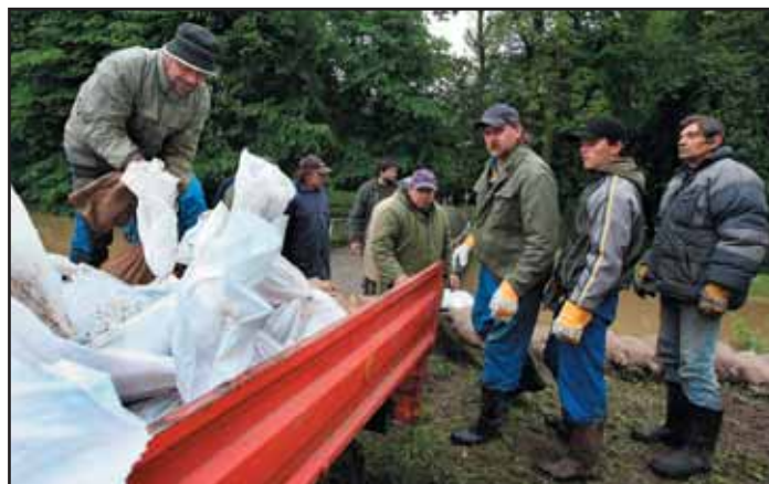
Pracovníci obce pytlama z písku zpevňují hráze. zdroj: kroměřížský deník.
