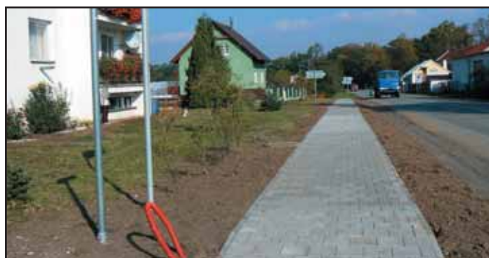
Nový chodník na ulici Tlumačovská.
