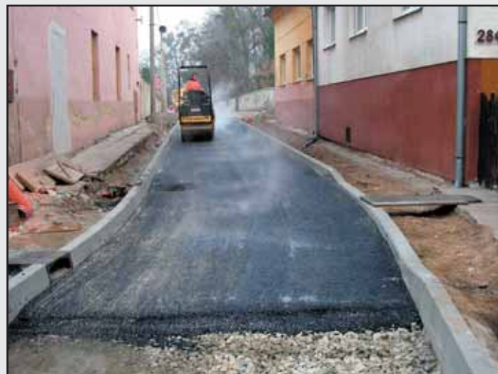
Parková ulice při rekonstrukci.
